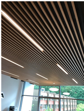
Lamelių ir linijinių šviestuvų įrengimo pavyzdys (Didžioji posėdžių salė)
